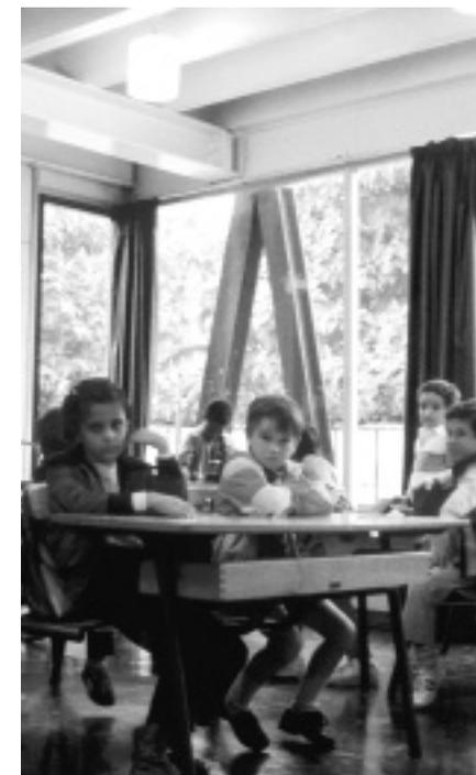
Les éléments porteurs en forme de compas sont visibles de l'intérieur et de l'extérieur et participent au discours architectural
