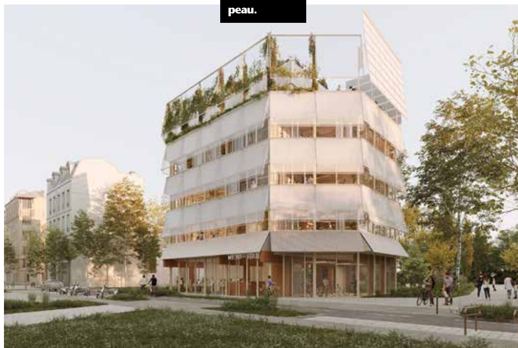
© Guillaume Ramillien Architecture-auteurs.studio
