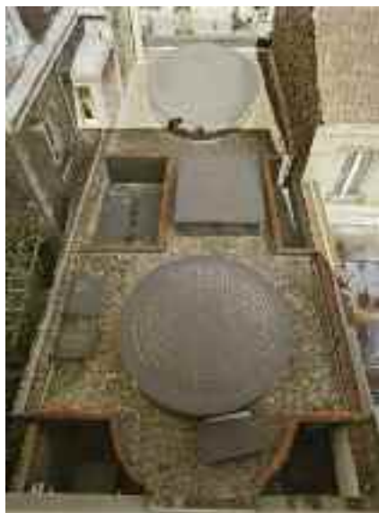
Toiture du 57 bis rue Hoche.
