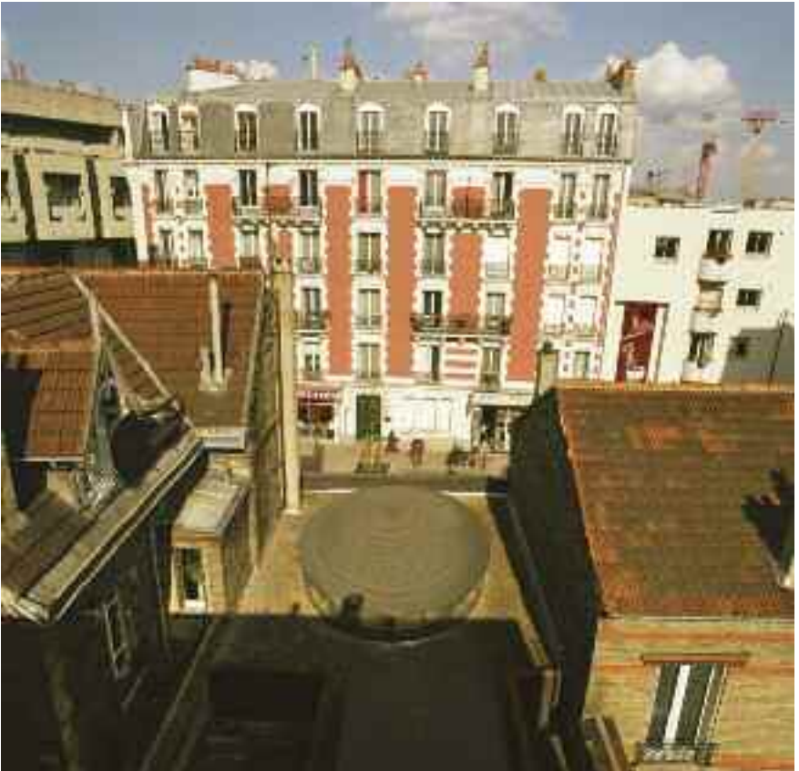
Le bâtiment du 57 bis de Tanalias n'occulte pas les effets de toiture de celui de Letailleux.
