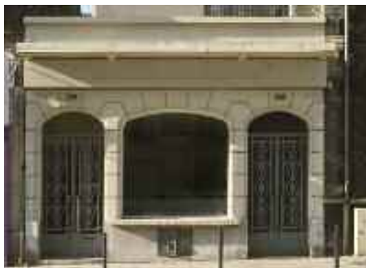
Façade du 57 bis rue Hoche.
